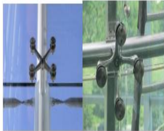
Figure 86: Croix (attaches) et rotules en acier inoxydable
