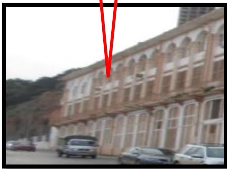
Le rythme suivis dans la façade principale de l'Usine de tabac
