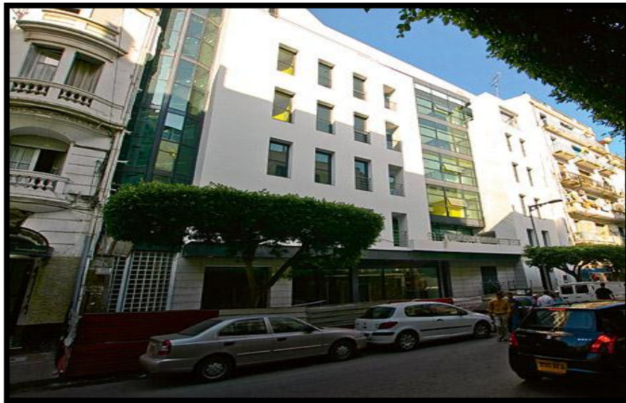
Figure 67: La façade principale de l'Historial, Alger
