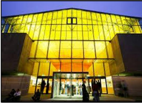
Figure 43: façade principale de l'ex friche industrielle
