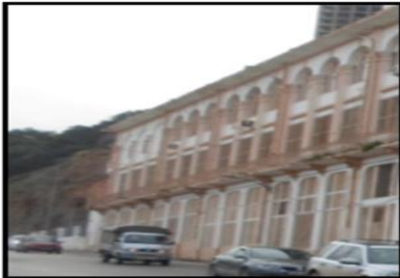
Figure 65: Façade de l'usine du tabac Bastos
