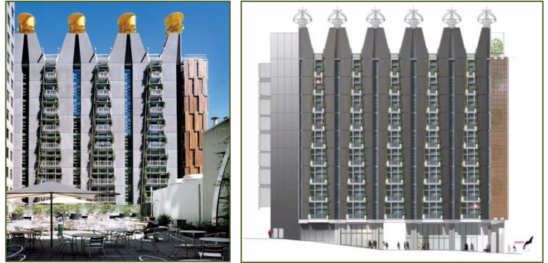
Figure 24 : façade nord de CH2
