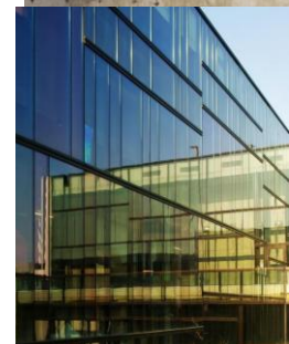
Figure 64. Revêtement des murs
