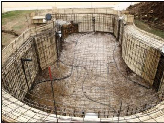
**Figure 148.** Ferrailage du bassin
