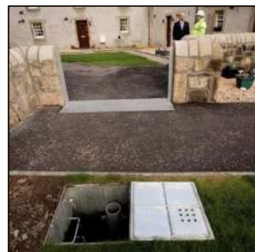
Photos 18: une fosse de service
