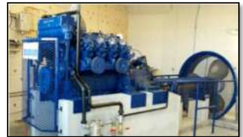
Photos 7: Moteur Baudoin et hélice
