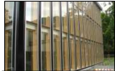
Photos 51 : exemple de mur rideau en bois et en verre
