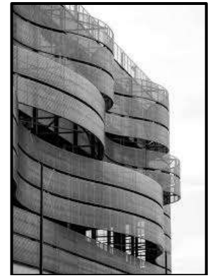
Photos 50: façade en métal déployé
