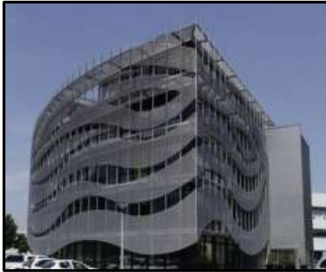
Photos 49: façade en métal déployé
