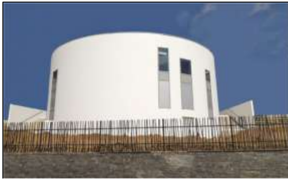
Photos 23 : exemple de mur courbé préfabriqué en béton armé
