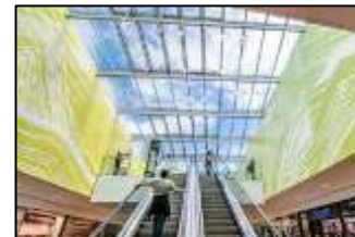
Photos 63 : éclairage zénithale
