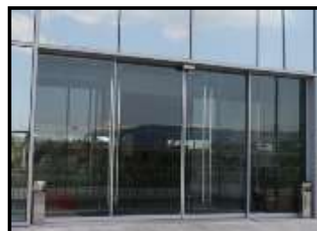
Photos 68: exemple d'une porte mécanique coulissante
