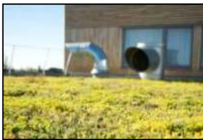
Photos 8: Toit végétalisé
