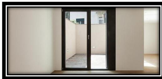
Figure 29 : exemple de Porte double battant
