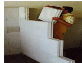
Fig125 : cellules en sy porex
