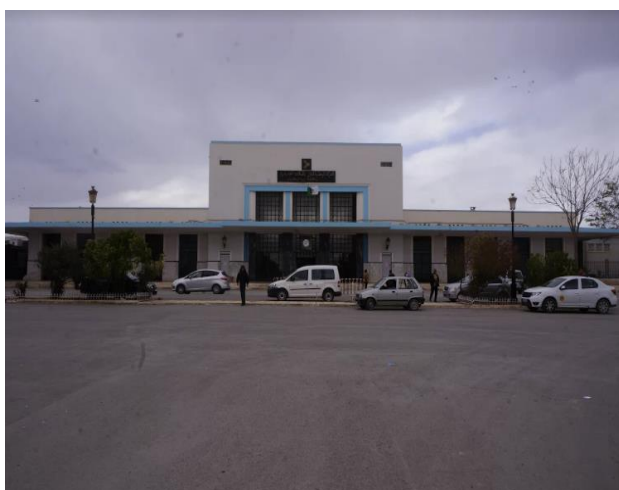
Figure 58: Equipement de Service, Gare Ferroviaire .Source : Auteurs.
