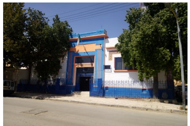
Figure 55: Equipement administratif, Sonelgaz. Source : Auteurs
