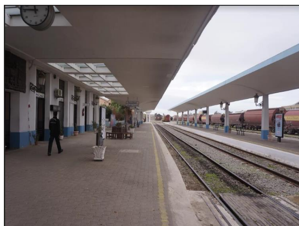
Figure 57: Equipement de Service, Gare Ferroviaire .Source : Auteurs.
