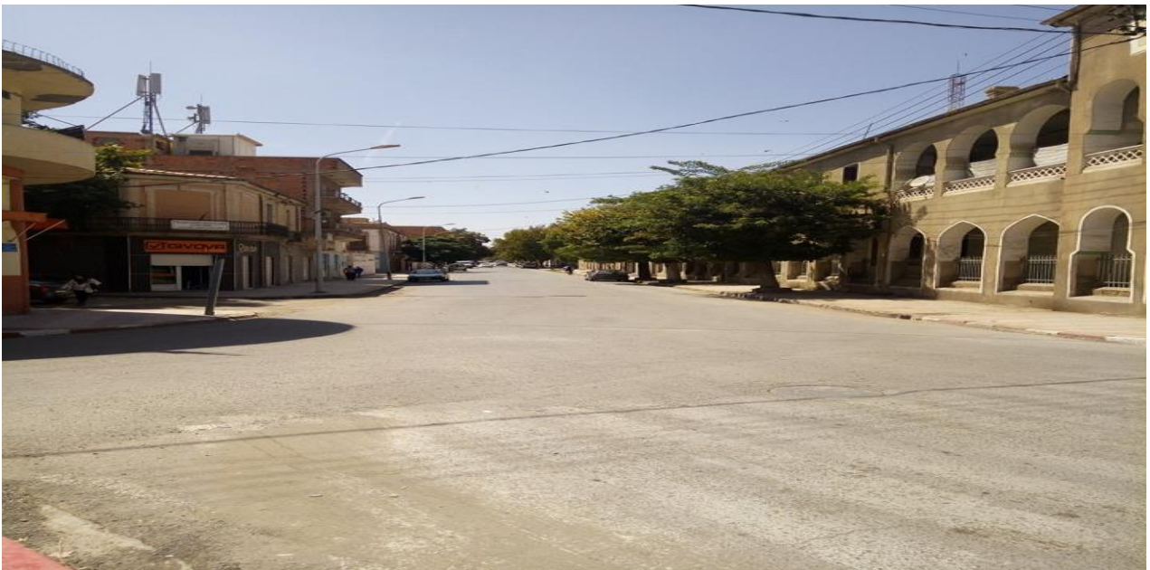
Figure 64 : Boulevard lieutenant Khelladi .Source : Auteurs.
