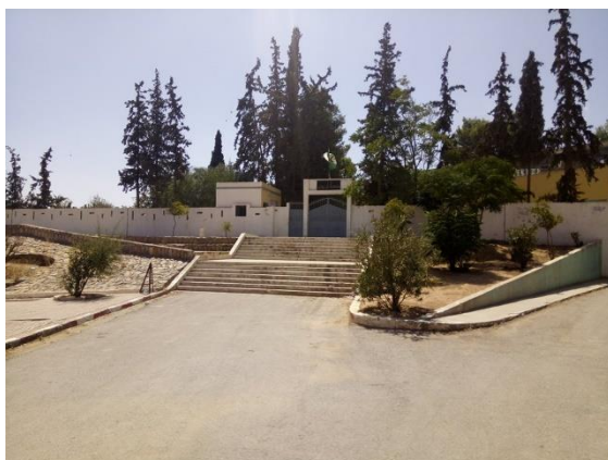
Figure 48: équipement éducatif, collège .source Auteurs
