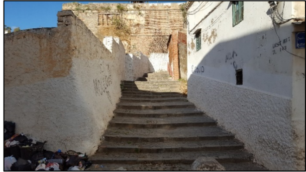
Figure 35 la rupture visuelle et spatiale causée par le mur de soutènement. Source : auteurs. Le 17/02/2017
