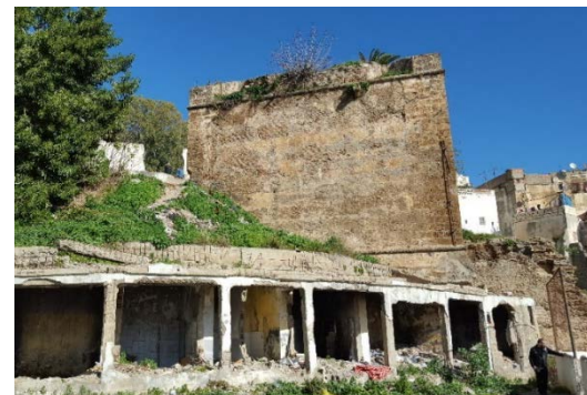
Figure 54 le bastion 8. Source : auteurs. le 07/02/2017
