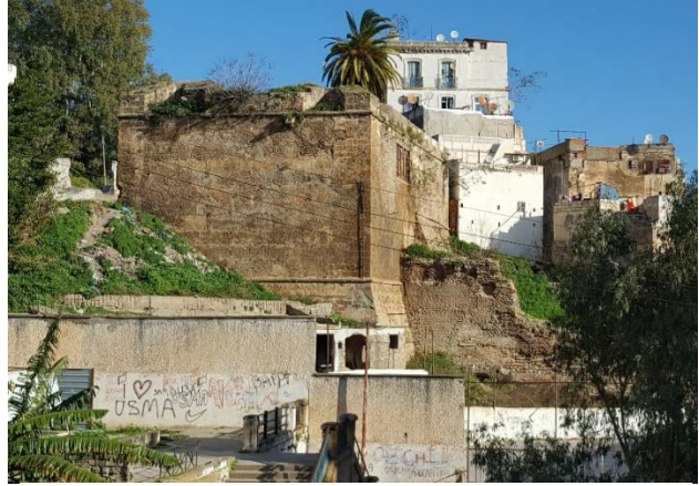
Figure 134 : Vue sur le bastion 8. Source auteurs, le 07/02/2017
