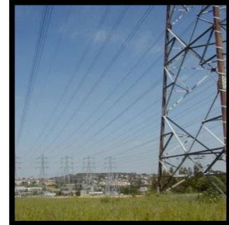
Photo 58 : Nombreuses lignes électriques
