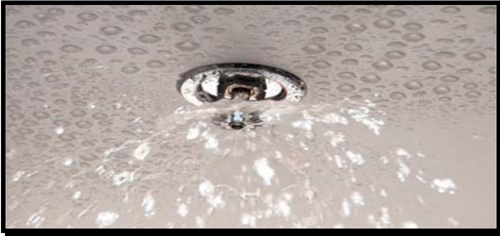
Fig. 4.30 : Représente les gicleurs automatiques
