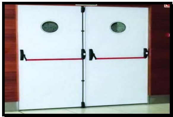
Fig. 4.15 : représente une porte coupe-feu avec deux battants
