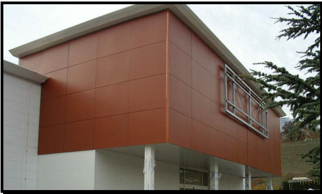
Fig4. 12 : Représente des panneaux coupe-feu
