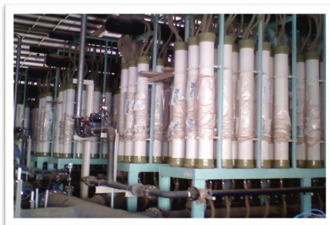
Figure n°14 : Représentation d'un train de membrane d'ultrafiltration
