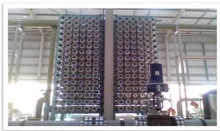
Figure n°17 : Représentation d'un train de système d'osmose inverse.
