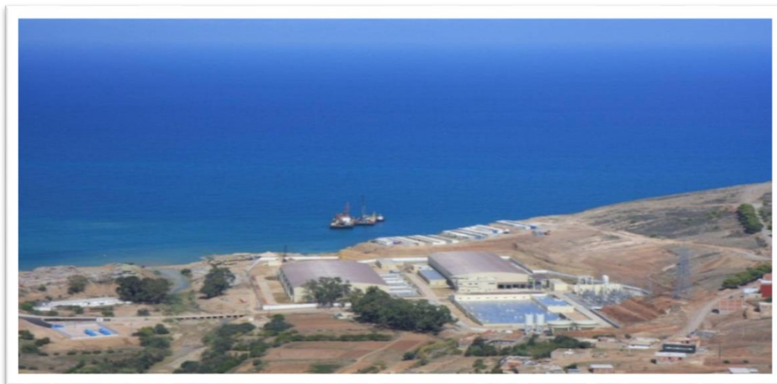
Figure n°12 : Station de dessalement de Souk Tlata réelle
