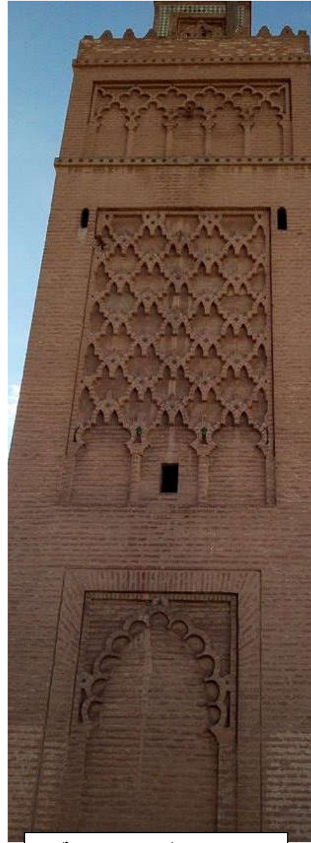
الصورة رقم 40 الواجهة الشمالية الغربية للمئذنة
