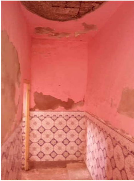
الصورة رقم 61 سقيفة المدخل حاليا
