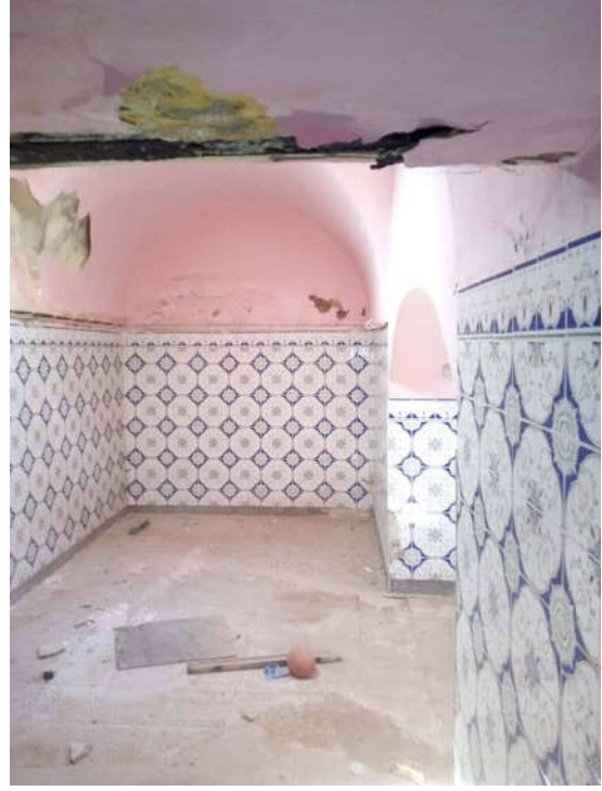
الصورة رقم 64 غرفة الباردة
