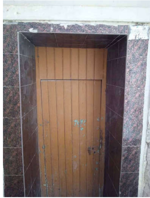
الصورة رقم 60 المدخل الرئيسي للحمام
