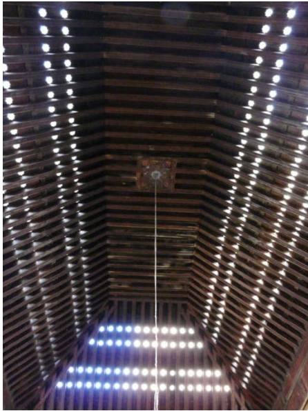
الصورة رقم 22 تسقيف الداخلي للميضاة
