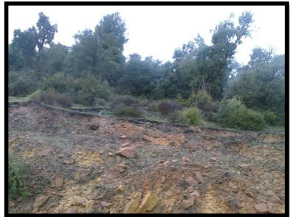
Station n° 2 : Zarifet
