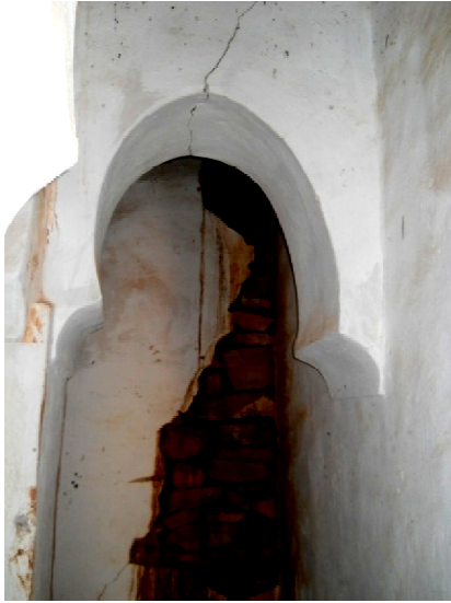
الصورة رقم (42): تلف طبقة العزل المشككة للسطح. الصورة رقم (43): تبين سيلان مياه الأمطار على الواجهة الداخلية للضريح وانفصال التليبيسات.
