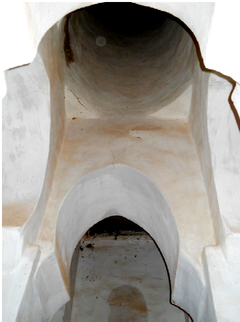
الصورة رقم (31): العناصر المعمارية الحاملة للقبة (الأقواس والحنايا الركنية)
