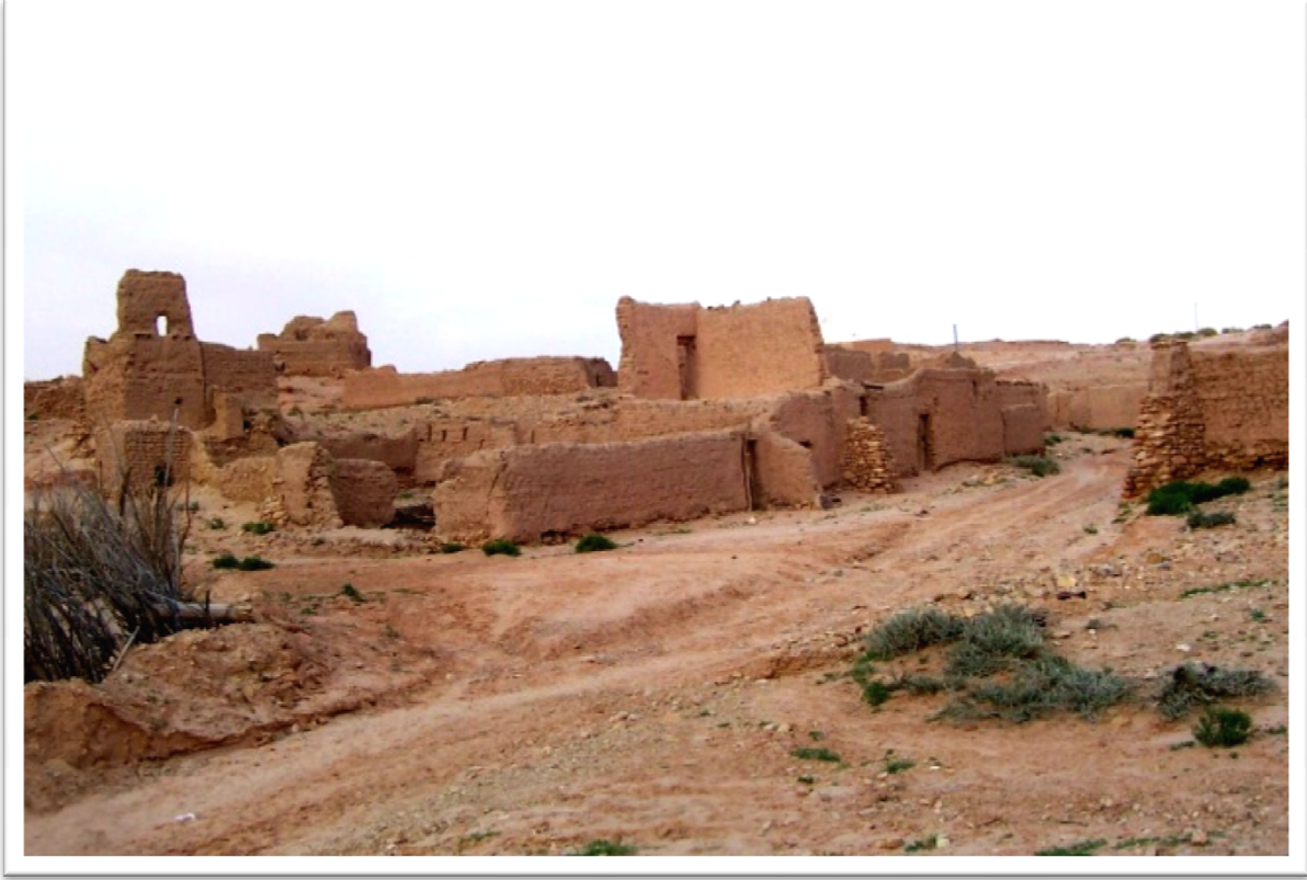
الصورة رقم (11): منظر عام لمساكن القصر.
