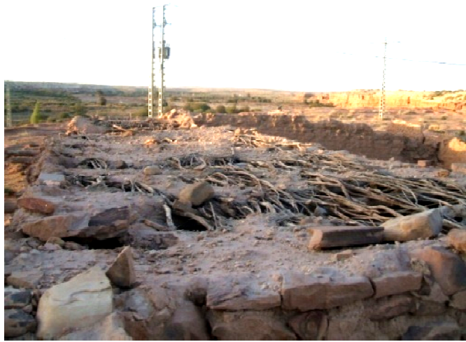
الصورة رقم (42): تلف طبقة العزل المشككة للسطح. الصورة رقم (43): تبين سيلان مياه الأمطار على الواجهة الداخلية للضريح وانفصال التليبيسات.
