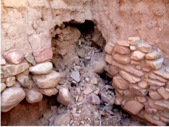
الصورة رقم (41): تبين سيلان مياه الأمطار وتأثيرها على الأساسات.
