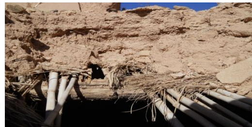
الصورة رقم (25): مقطع طولي لسقف مكون من جذوع الأشجار والقصب.
