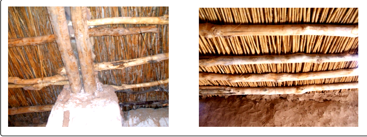
اللوحة رقم (26): نماذج من الأسقف المكونة من العوارض الخشبية والقصب.
